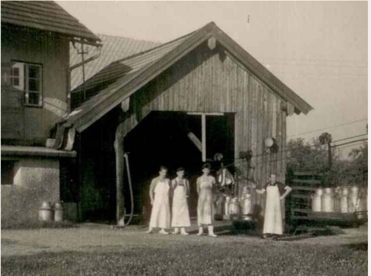
Talstation der Materialseilbahn von der Achartinger Käserei über Mitterstätt nach Buchstätt am Haunsberg. Käser von links nach rechts: Franz Matzenberger, Hans Kühleitner, Hermann Stadler, Franz Strohbichler (Bild: Raggei Bräu)
