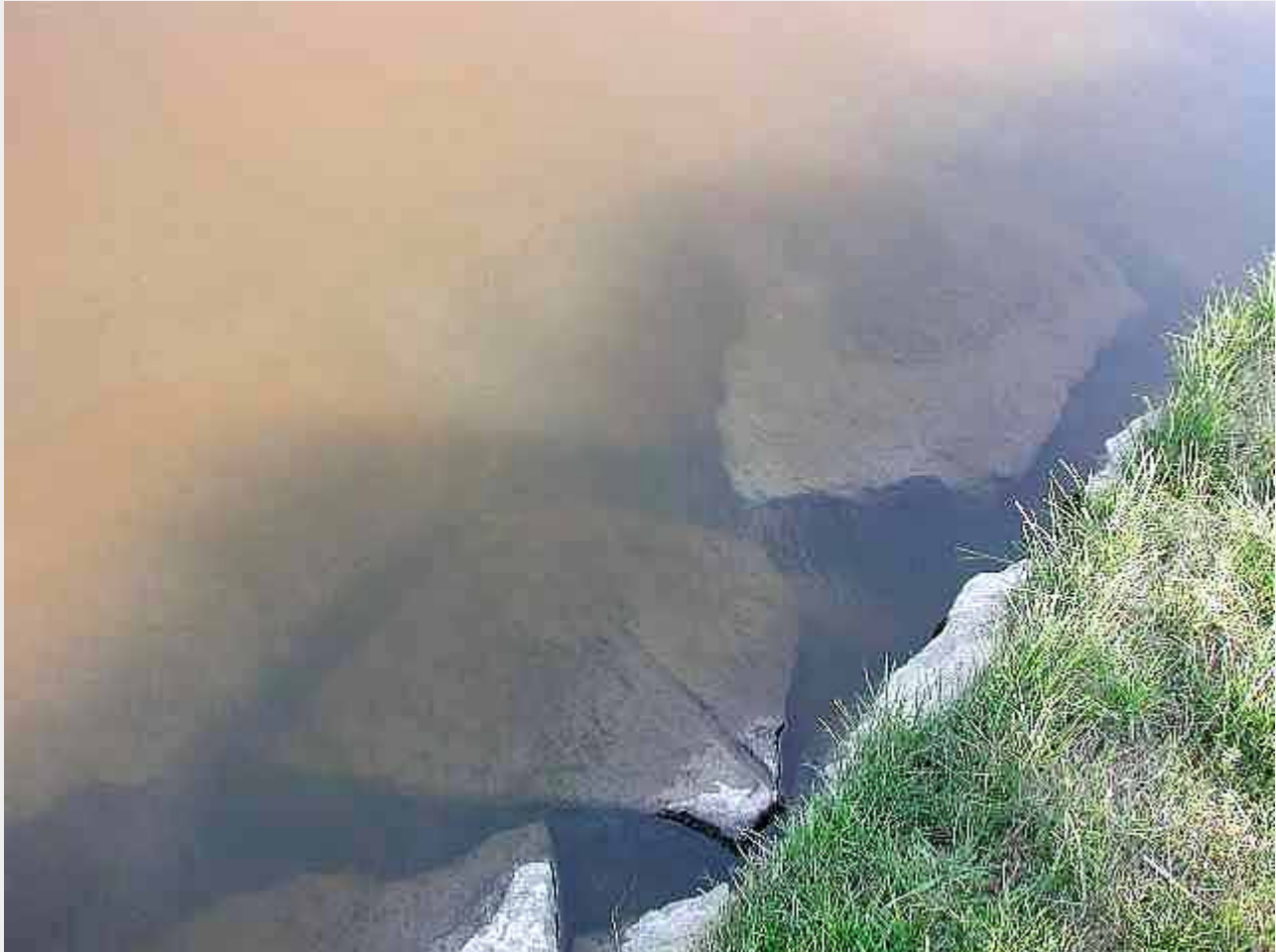
Das Bachbett wurde mit Steinen ausgelegt.
